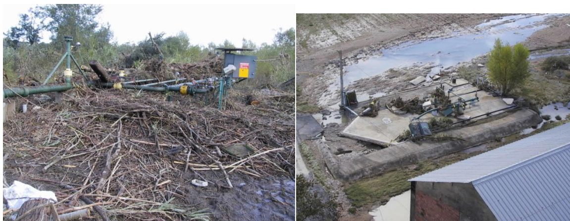
Figure n° 28 : Poste de Brignon et d'Ales Saint-Hilaire lors des inondations de 2002
